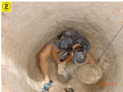
② 掘り出した土や出てくる水をバケツで汲み上げる
