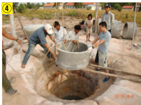
④ ロープを使い、人力でコンクリートのパイプを穴に投入
