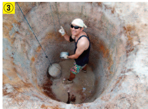
③ 皆で協力して深さ4m弱まで掘る
