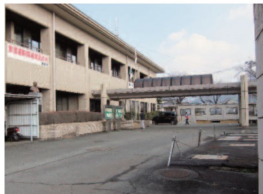
西原村役場庁舎 駐車場は浄化槽の部分が隆起
