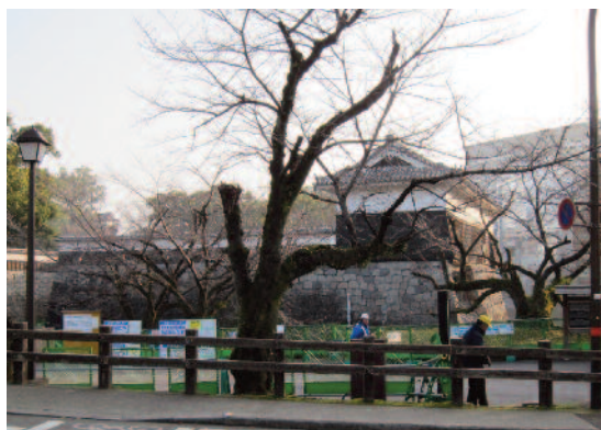
工事中の熊本城周辺
