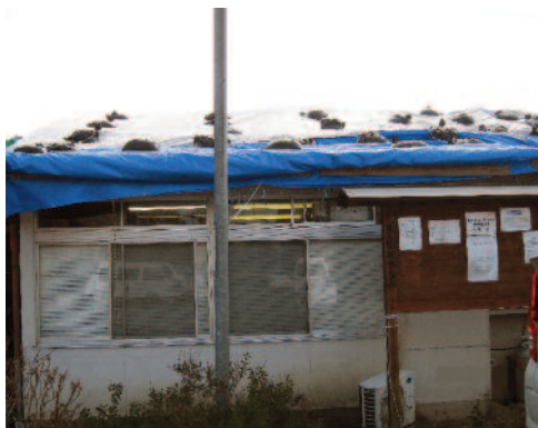
ビニールシートの上に石が置かれている屋根
