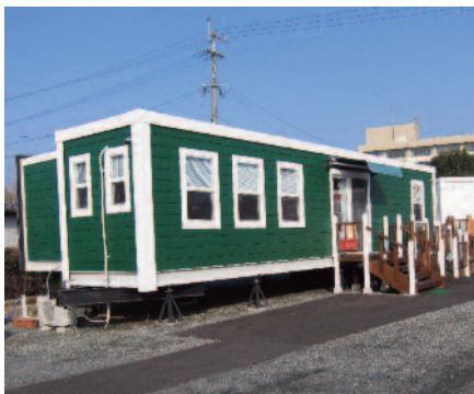
トレーラーハウス 床下にタイヤが付いていて移動可能
